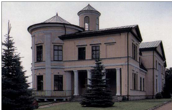
Zespół pałacowy - elewacja północno - zachodnia
