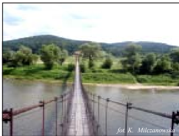
Kładka nad Sanem w miejscowości Wara
