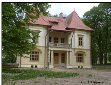
Odremontowany budynek dworu
